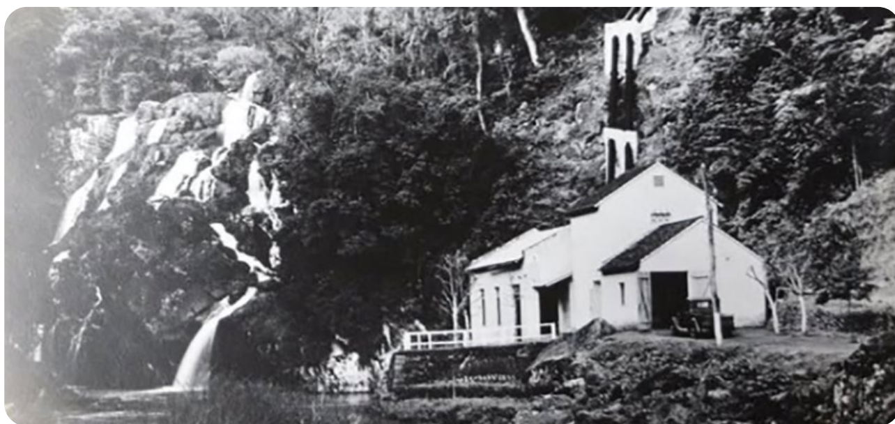
Usina da Picada 48, na Cascata de São Miguel, inaugurada em 1913, a primeira do Rio Grande do Sul
